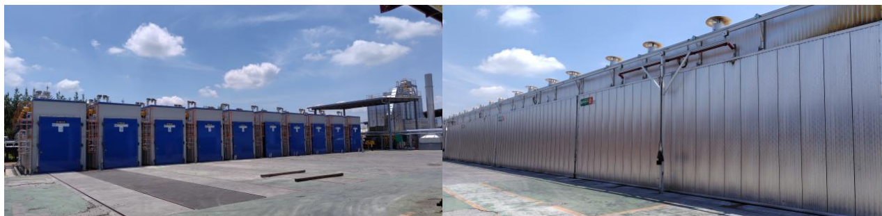
建材の乾燥設備
